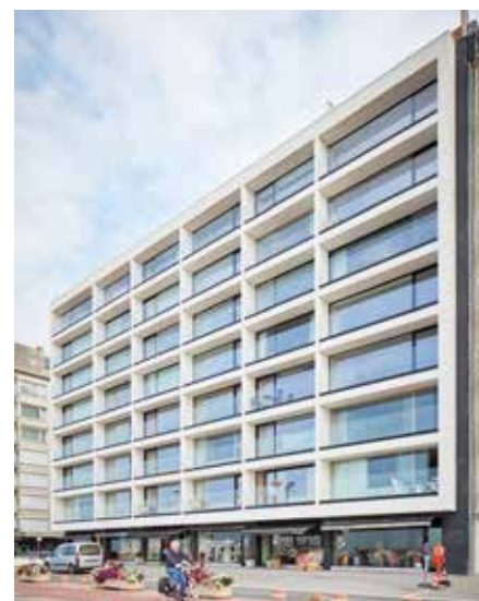
Een nieuwe gevel in prefab beton draagt bij tot een architecturale verfrissing van de zeedijk van Knokke en voegt bovendien 50 jaar toe aan de levensduur van 'Le Globe'. - © Enjoy Concrete - Furnibo - Beeldcollectief
