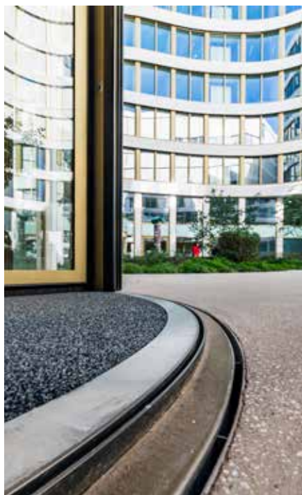
Maatwerk roestvrij staal gebogen kanalen; BNP Paribas Fortis Brussel
