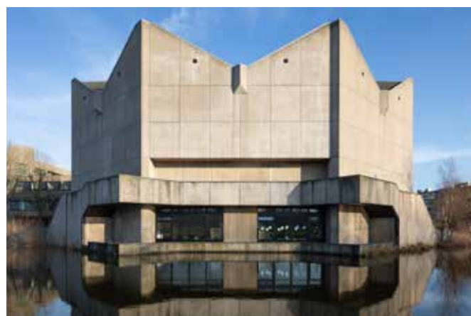
Campus Woudestein, Erasmus Universiteit, Rotterdam - Architect: Cornelis Elffers, Abram van der Heijden en Kees Hoogveen (1970) - BRUUT-Score ****
