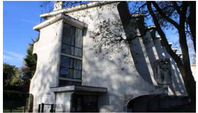
Naast de traphallen wordt, volgens het nieuwe ontwerp, een travee opgeofferd om liften te plaatsen.
