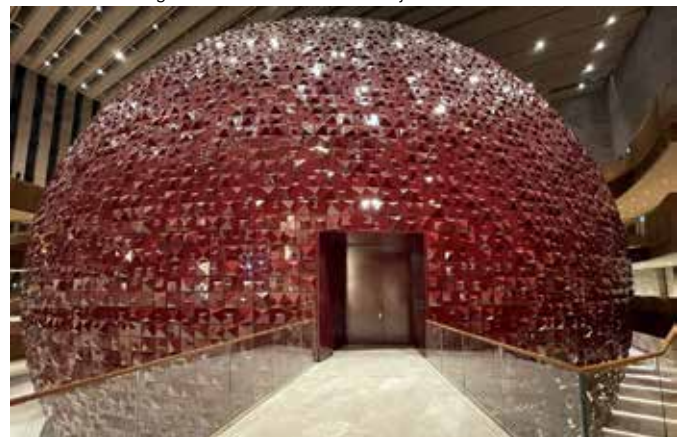
Geluidswerende en brandwerende deuren bij AKM Cultuurcentrum in Istanbul
