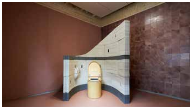
Een geprinte muur met elementen uit de waterzuivering van Omlab en een droogtoilet (ecosave.com) - © about today
