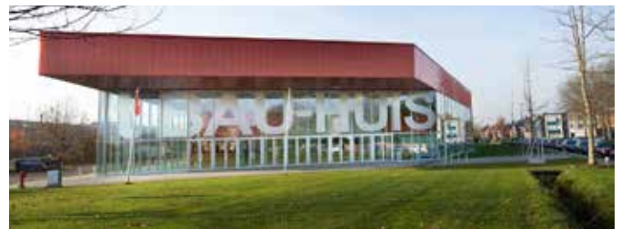
Geluidswerende deuren in beurs- en evenementencentrum Bau-huis in Sint-Niklaas
